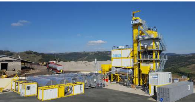
УКРАИНА – Установка ПБВ modiFALT20 до 20т/ч
